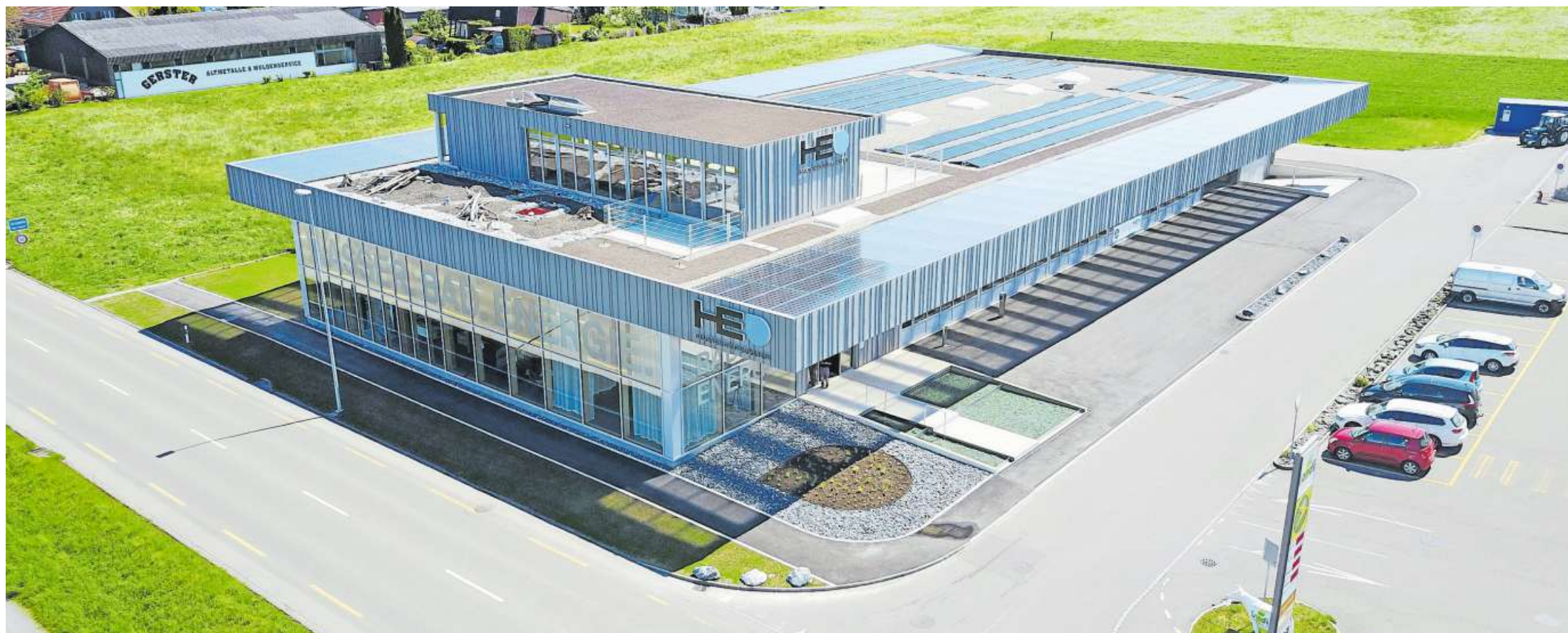
Im Neubau ist eine grosszügige Badausstellung sowie Büro-, Werkstatt- und Lagerräume angesiedelt. Das Industriegebäude erfüllt den Minergie-A-Standard.
